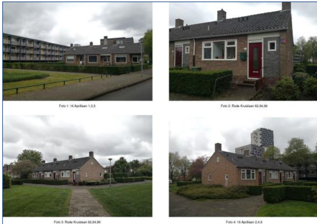
Figuur 2.3: Het plangebied gezien vanaf de verschillende woonblokken in de wijk.
