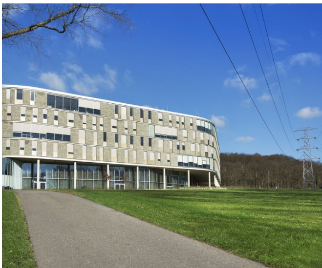
Kantoorgebouw in het groen. Tennet, Arnhem © GROUP A. Photo: Ossip van Duivenbode
