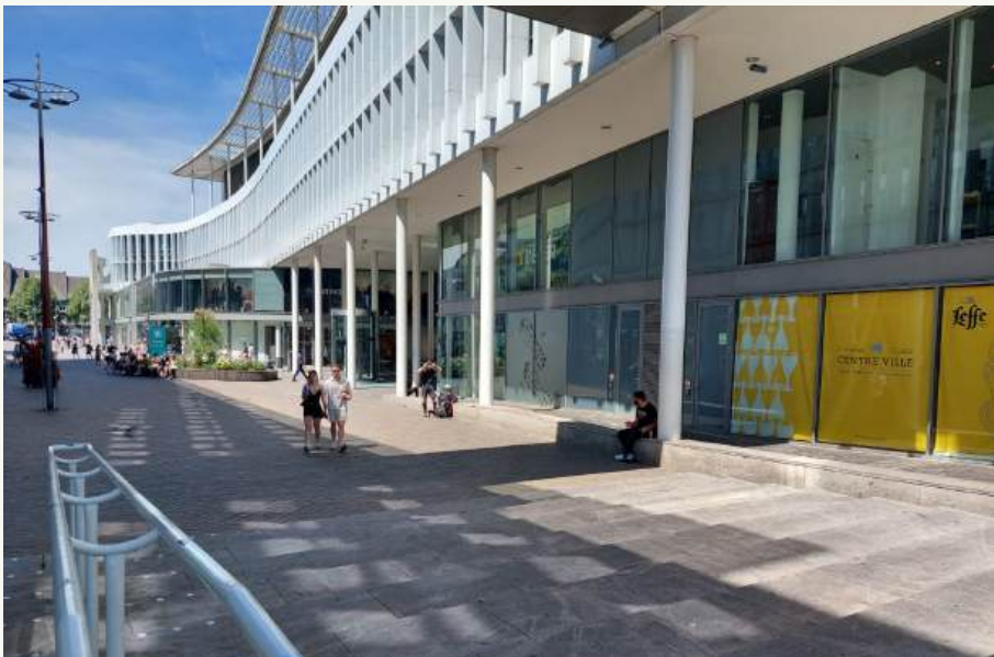
Mosea forum in Maastricht heeft een heldere plint. Er is duidelijk visueel onderscheid in onderste twee plintlagen t.o.v. rest van het gebouw. Er is balans tussen open en dichte delen en een fijne ritmiek in de gevel door de kolommen.
