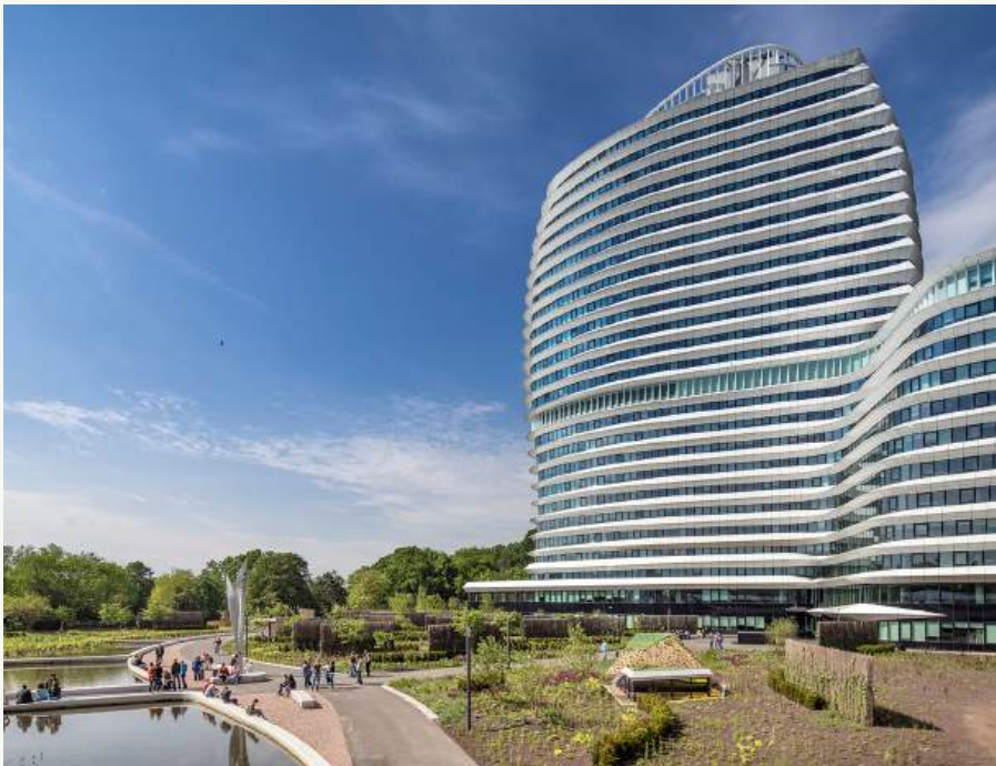
Het bestaande Rijkskantoor met de 2 laagse, donkere plint en witte horizontaal vormgegeven verdiepingsvloeren. Het einde van het gebouw is ontworpen als uitstekende enterugelegen kam.
