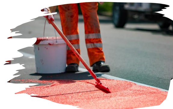
Figuur 8 Referentie aanbrengen fietsstroken m.b.v. coating
