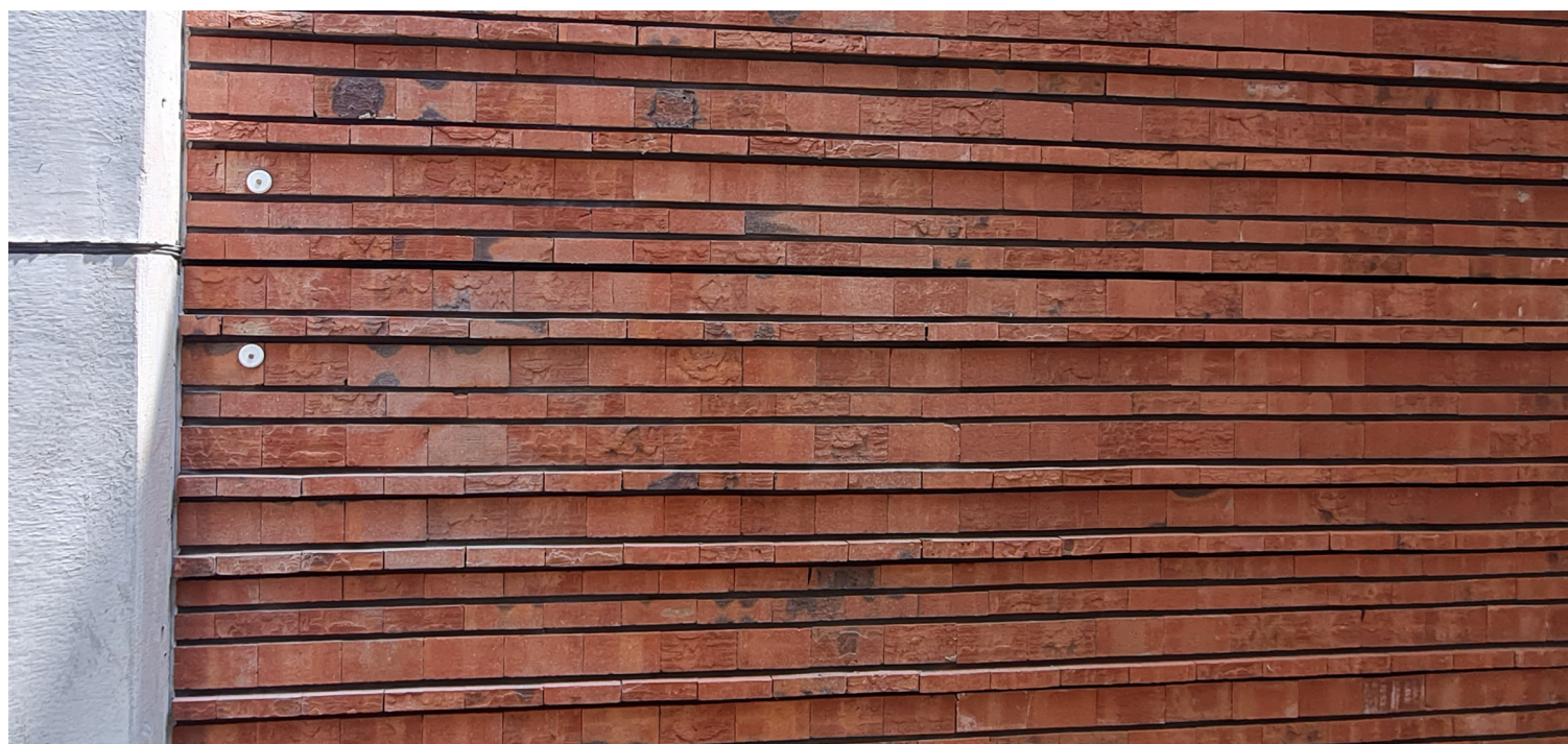
wanden insnijding - referentie metselverband en voeg
