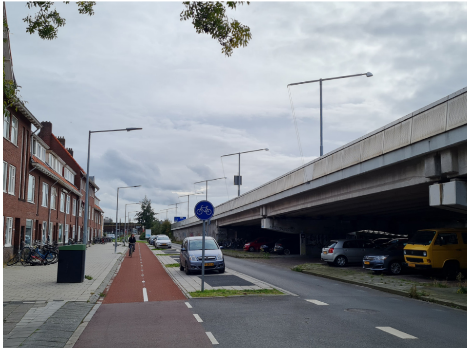
bestaande viaduct met gesloten leuningen zuidelijke deel
