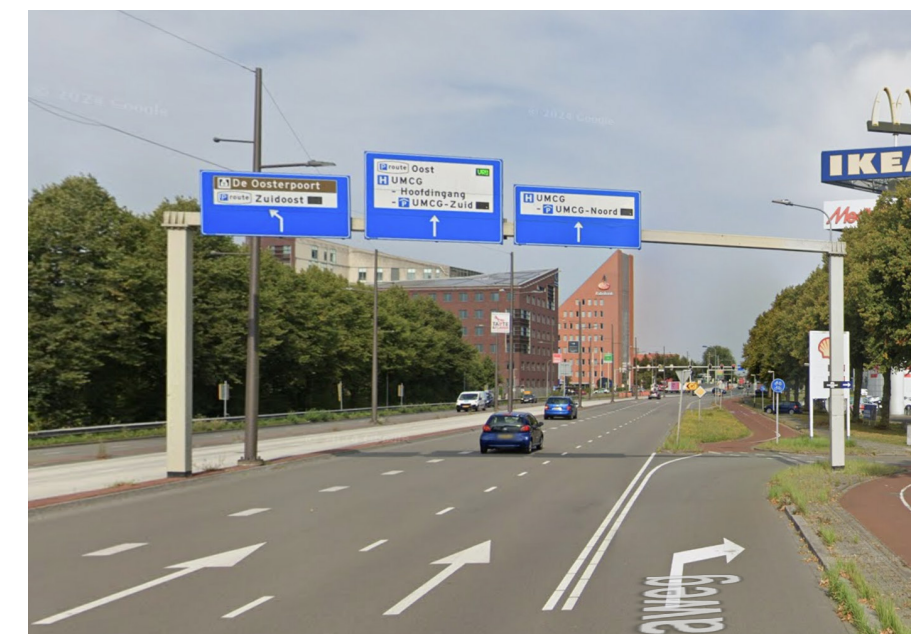
portaal met vierkanten buizen en coating
