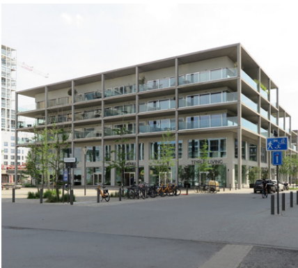
Alzijdig gebouw met tweelaagse plint
