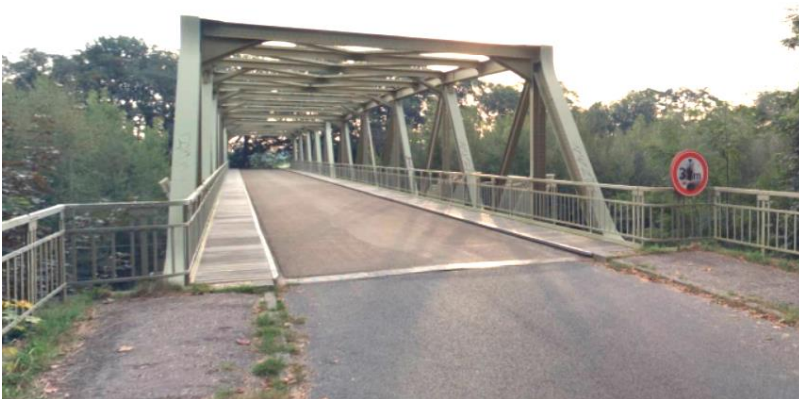
Bestaande spoorwegviaduct Viaductweg-Dalweg
