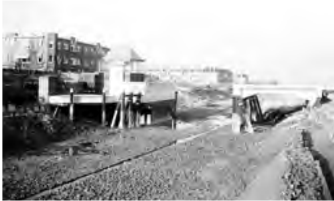
Aanleg Zaagmuldersbrug in 1938 (foto: Groninger Archieven)
