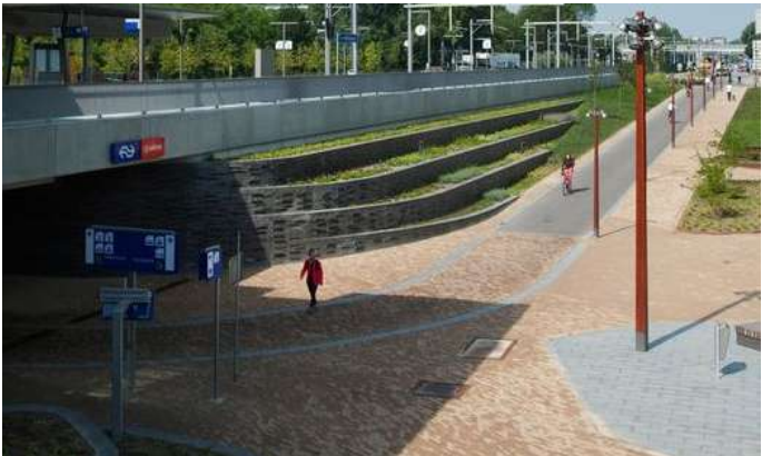
Station Europapark, Groningen; bij station Europapark komt de fietser ongeveer 3,5 m onder maaiveld. Bij een aquaduct moet de fietser naar min 11 meter en moet 3 keer deze helling worden geïntegreerd in stad.
