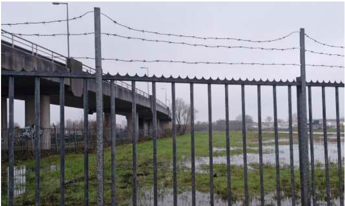
Busbaan brug aan de oostkant van het Van Starckenborghkanaal
