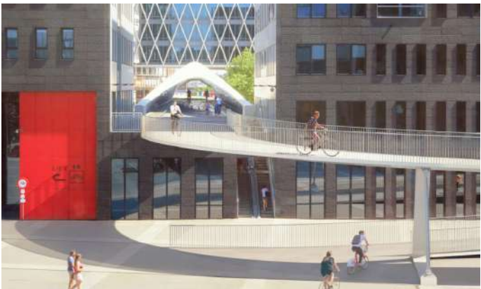
Fietspad tussen en op gebouwen, Parkbrug, Antwerpen
