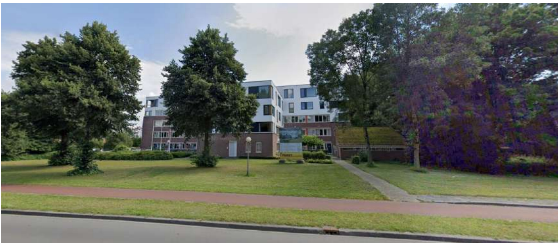
Figuur 3-13 Kantoorpanden Damsterdiep
