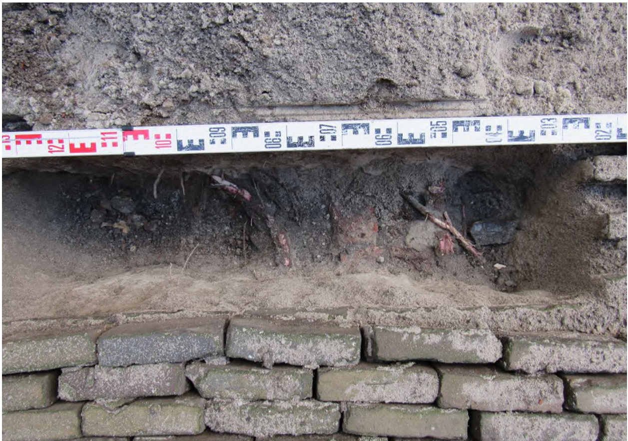
Profielkuil A, aanwezigheid van (historische) puinresten en beworteling
