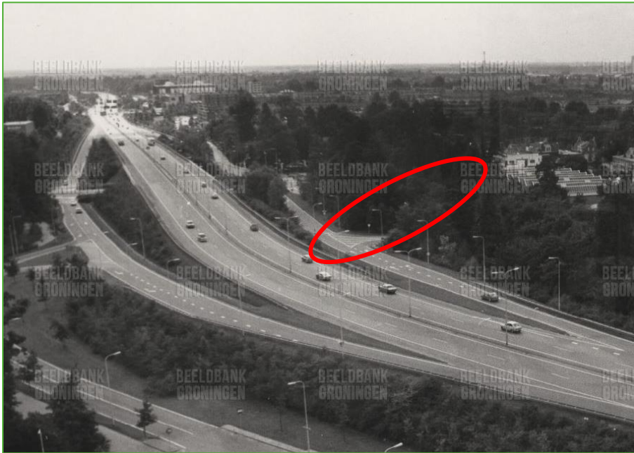
Afbeelding 5-1 afrit ter hoogte van het beoogde pad (bron: Beeldbank Groningen)
