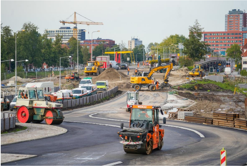
Werkzaamheden onderliggend wegennet ovonde Brailleweg
