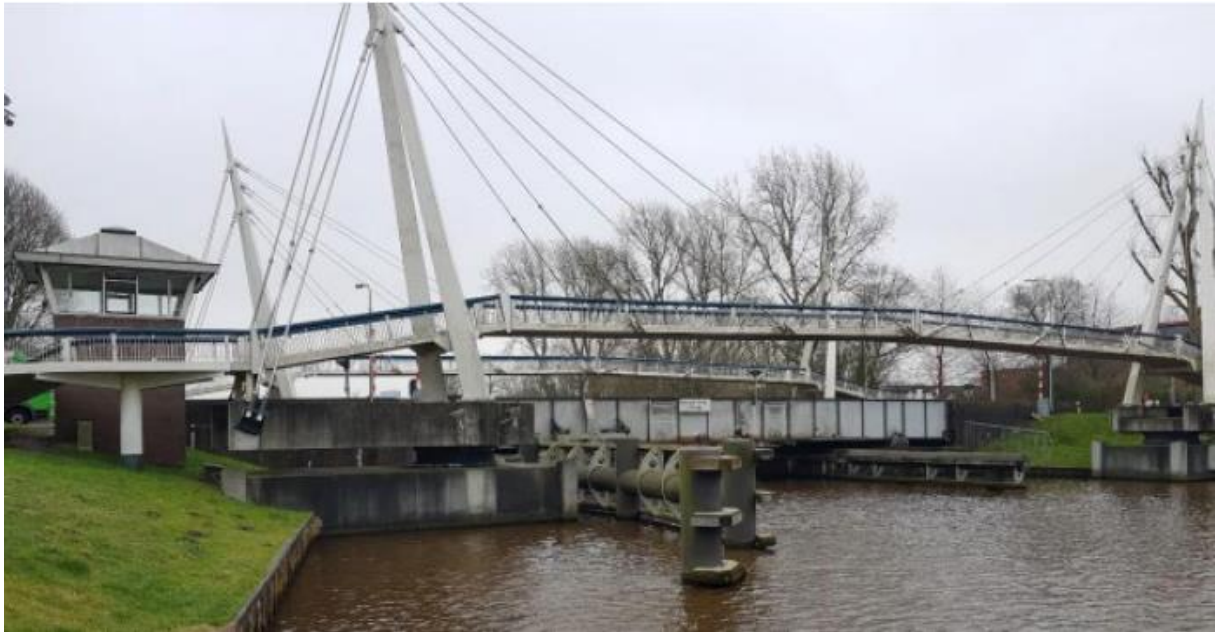
Voormalige toestand van de aangevaren brug met naastgelegen fietsbruggen
