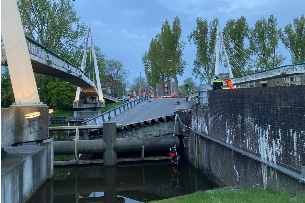
Figuur 2: De Gerrit Krolbrug na de aanvaring op 15 mei 2021 – foto RWS
