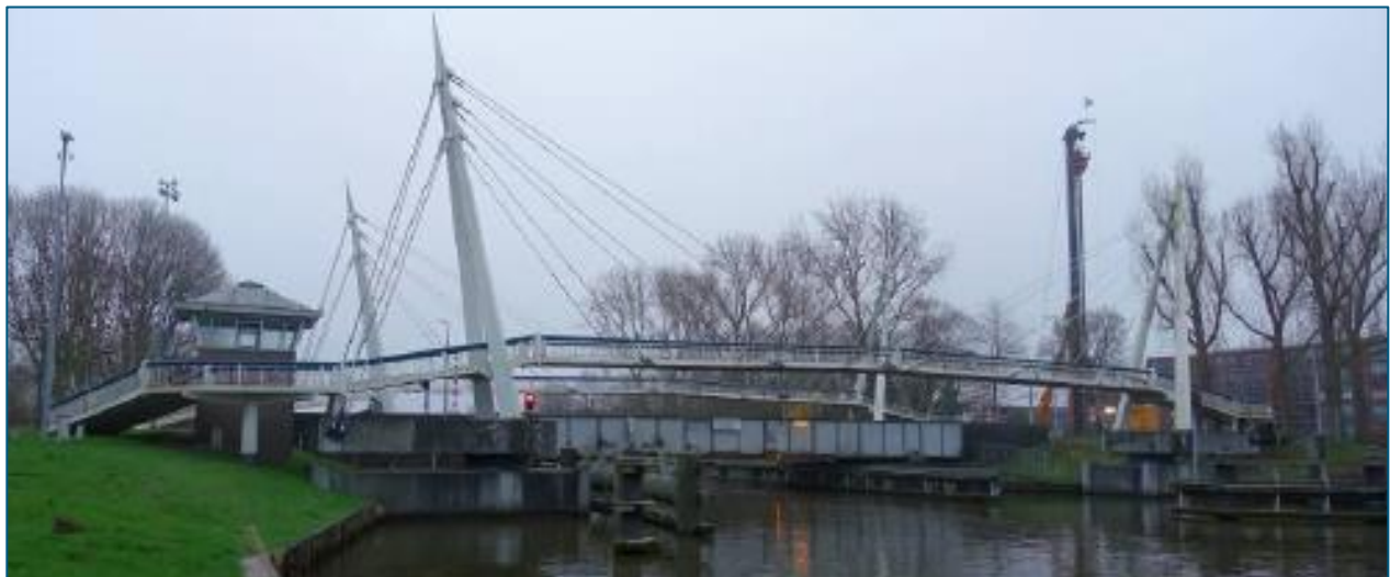
Figuur 31 Overzicht GKB met naastgelegen fiets-loopbruggen (bron: Bouwhistorisch onderzoek GKB)
