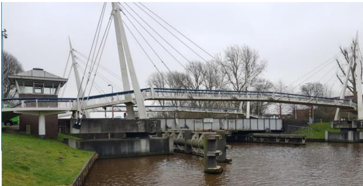
Figuur 1: De Gerrit Krolbrug voor de aanvaring in mei 2021
