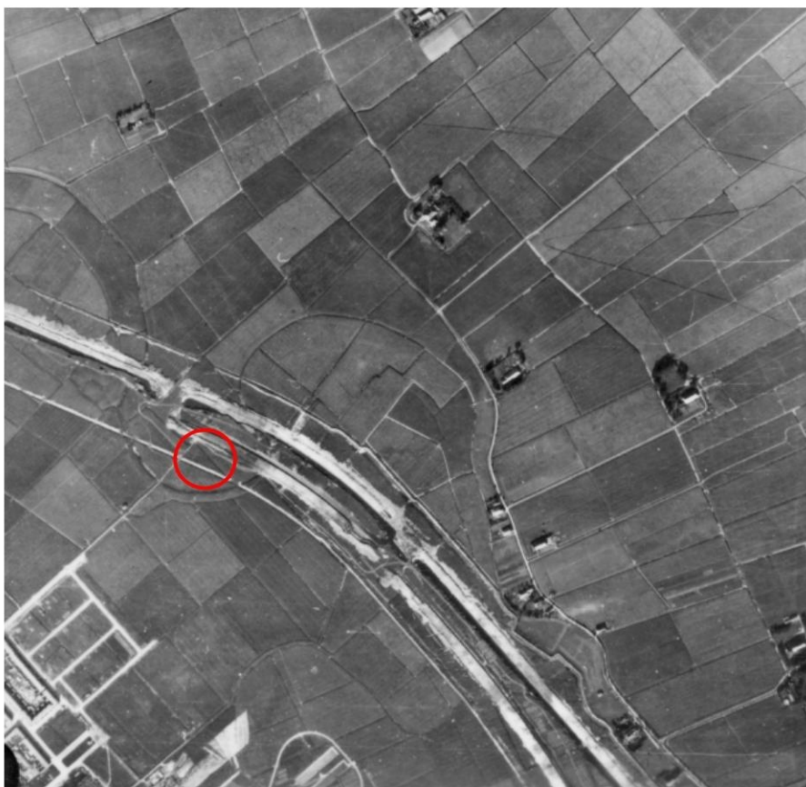
Afbeelding 1: Luchtfoto uit de jaren '20 van de vorige eeuw met daarop zichtbaar het graven van het Van Starkenborghkanaal. De globale ligging van het plangebied is roodomcirkeld.
