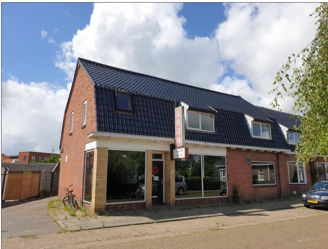
Figuur 1. Overzicht huidige situatie Middenweg 15, 17 en 19. Bron: eigen foto.
