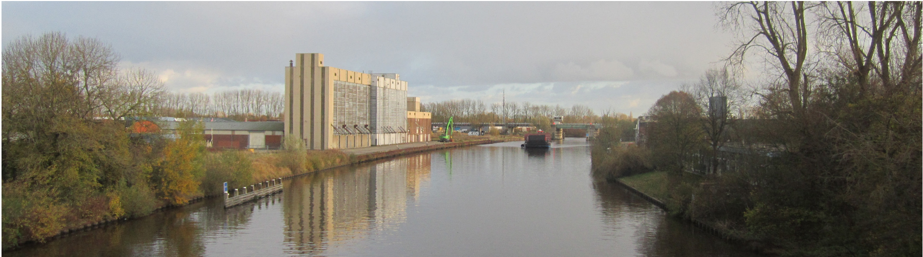
Van Starckenborghkanaal gezien vanaf Gerrit Krolbrug in zuidoostelijke richting
