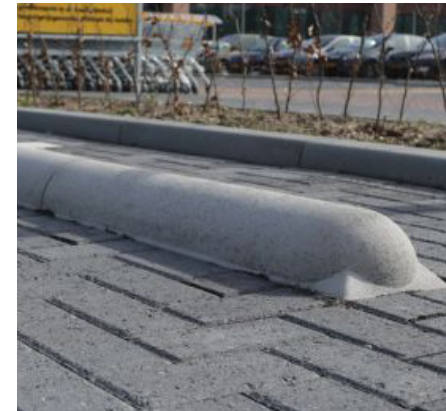
Stootband Parkeervak Antillenstraat 20x18x89 Struyk Verwo 1x rond met hoeken Slijtlaag passend bij materialisatie Antillenstraat
