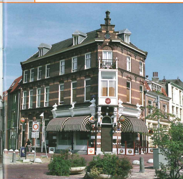
Het pand Kortestraat 17-18 werd in 1983 gerestaureerd en verbouwd als horecagelegenheid. Tevens werden zes woningen gerealiseerd. [FOTO: GELDERS ARCHIEF]
