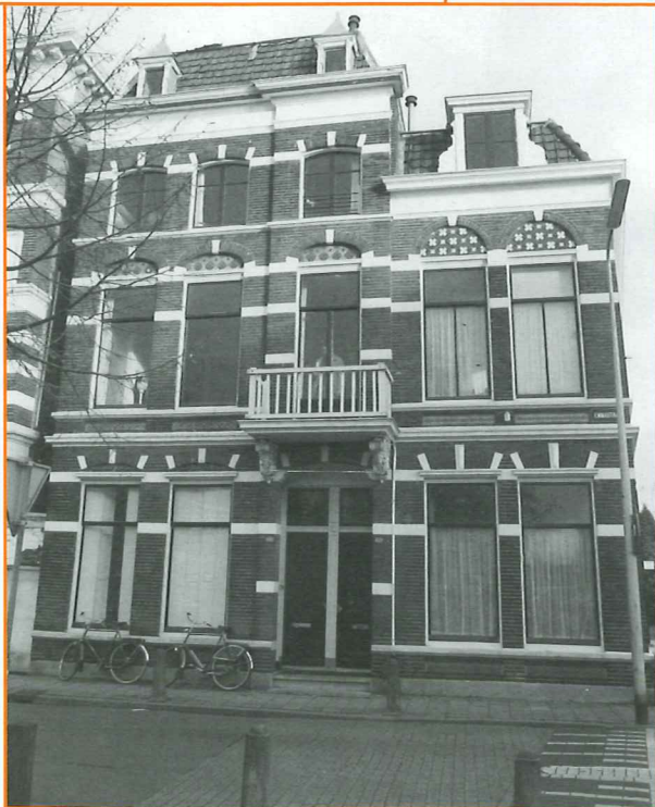
Emmastraat 55, 75-77/hoek Thorbeckestraat Het pand Emmastraat 75-77 werd on ca. 1885 gebouwd [FOTO: GELDERS ARCHIEF]
