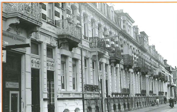
Spijkerstraat/Brusselse huizen Spijkerstraat, Brusselse huizen, toen. [FOTO: GELDERS ARCHIEF]
