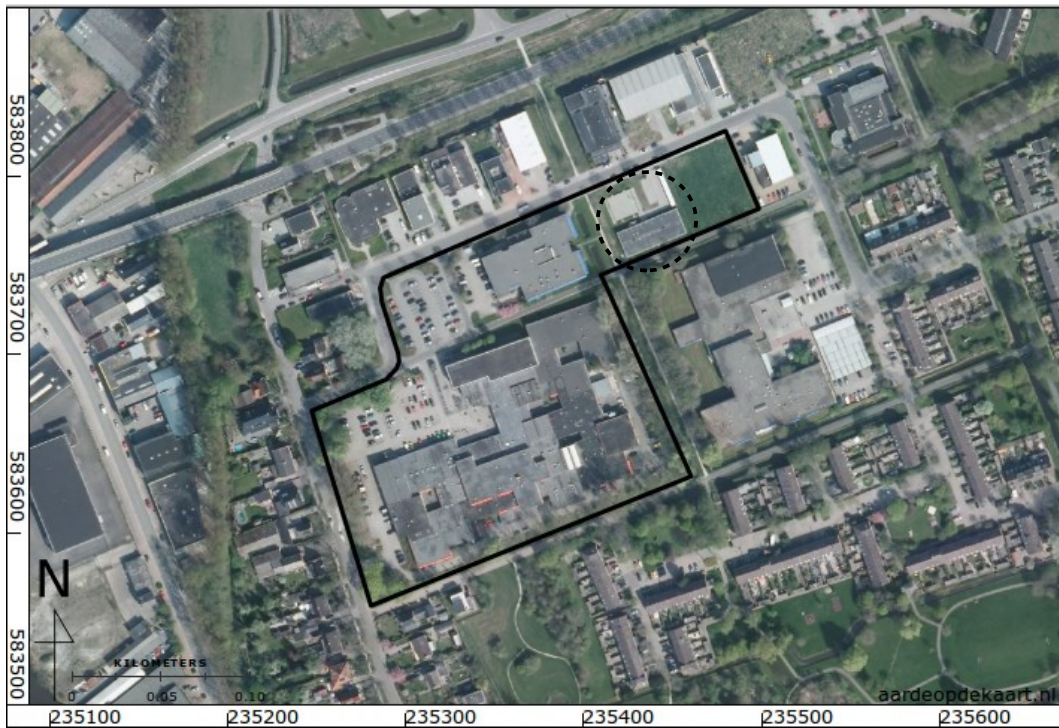
Figuur 3: Luchtfoto. De bebouwing in de cirkel is inmiddels gesloopt.
