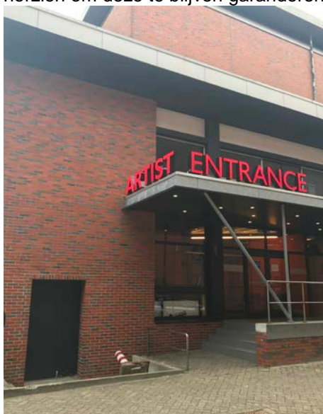
Figuur 1: situatie ter plaatse van de artiesteningang, waarbij een nooduitgang geblokkeerd wordt wanneer vrachtwagens in- en uitrijden
