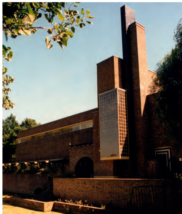
Amsterdamse School. Van Houtenschool Oliemuldersweg. Foto: gemeente Groningen.
