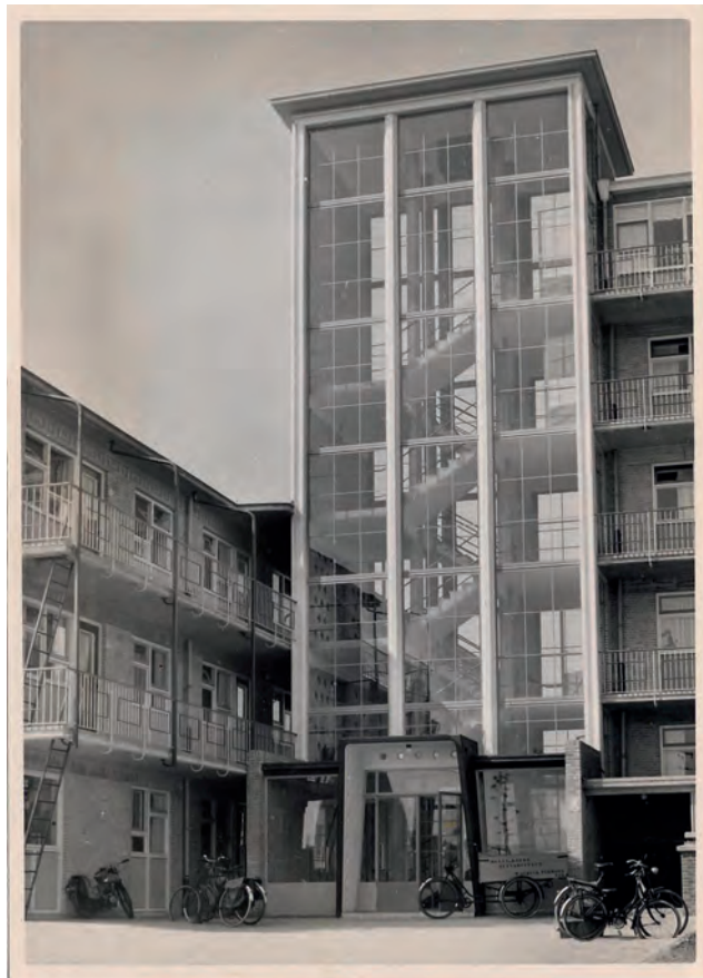
Naoorlogs gemeentelijk monument Westerland, trappenhuis. Foto: gemeente Groningen.
