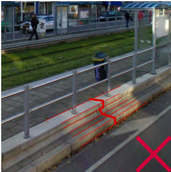
onrustig beeld: profilering te aanwezig, slechte aansluiting
