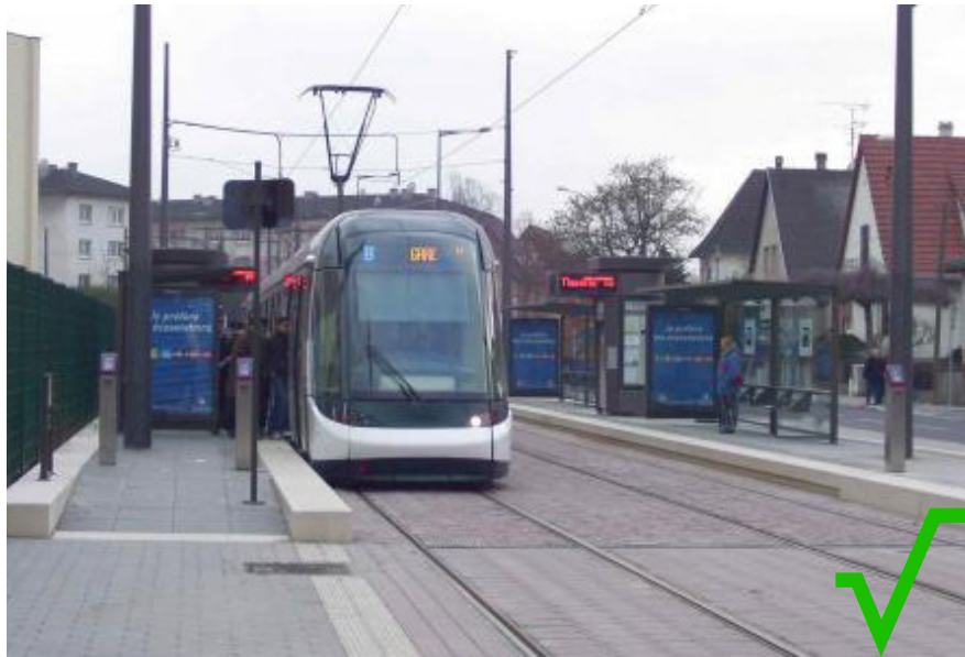
PVR ter plaatse van de halte loopt (subtiel) door in de PVR van de oversteekplaats
