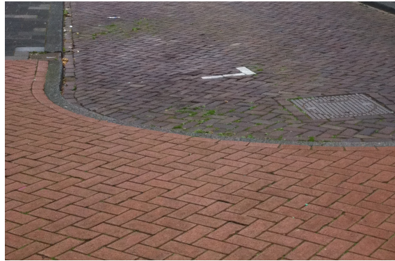
zone 1.2 Binnenstad: licht- en donkerrode gebakken klinkers
