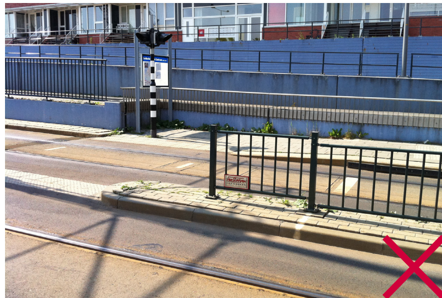
onrustig beeld door verschillend kleurgebruik en vormgeving van hekwerken
