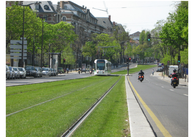
bvl-masten in breed profiel geplaatst
