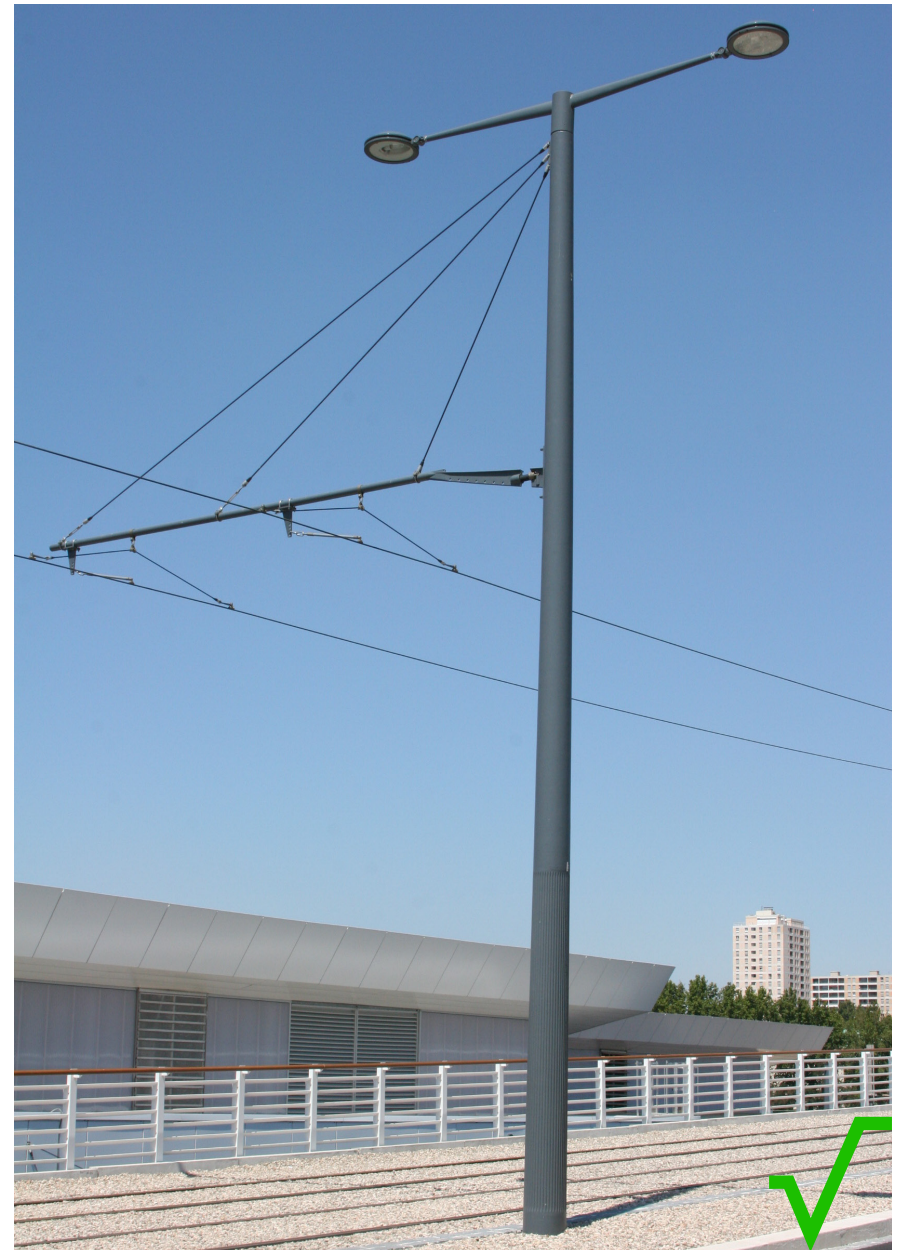
verlichting en bevestigingsmiddelen zijn subtiel geïntegreerd in het ontwerp
