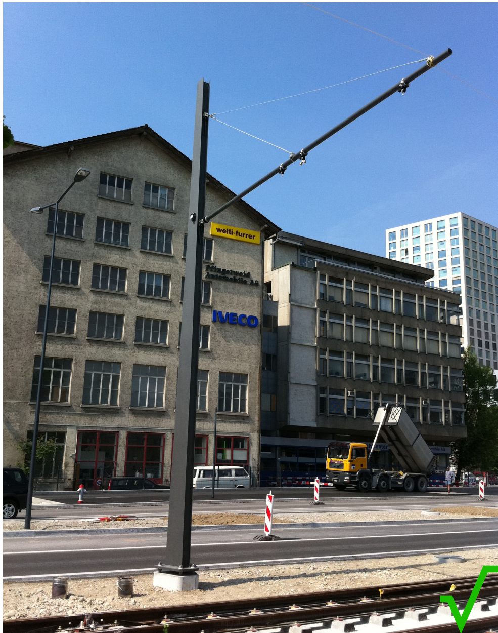
ranke, slanke en eenvoudig ontworpen mast; uithouder in kleur mast
