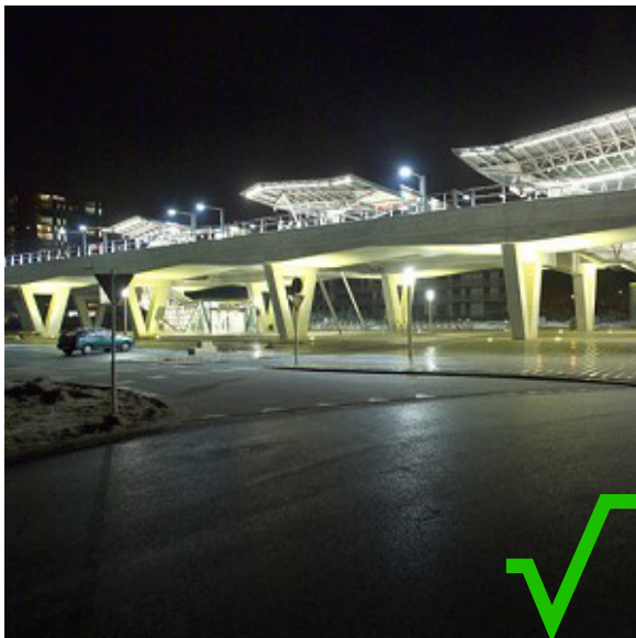
bijzondere verlichting onder viaducten
