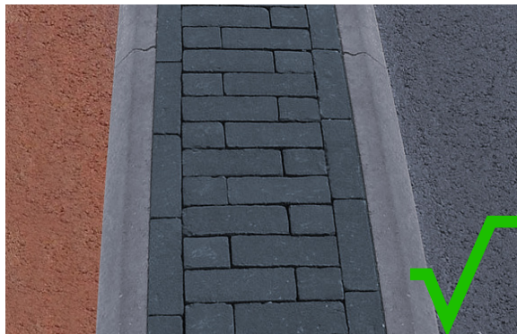
Overrijdbare strook in elementenverharding
