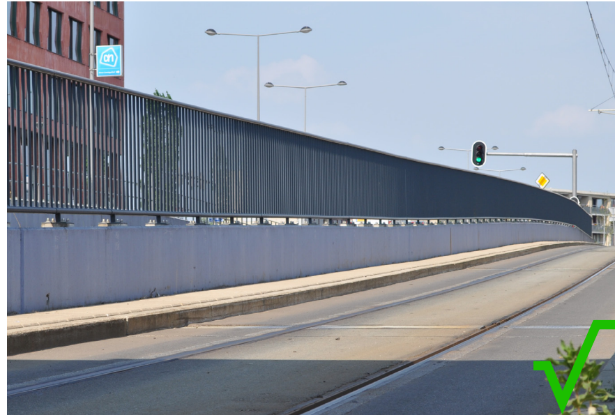
hekwerk uitgevoerd in strakke doorgaande lijn met terughoudende detaillering
