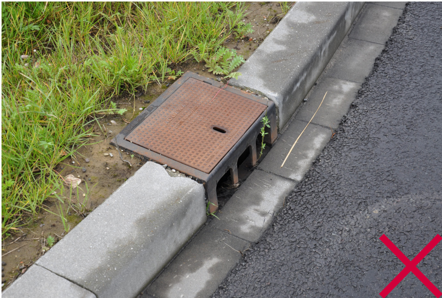
straatkolk niet geïntegreerd in opsluitband
