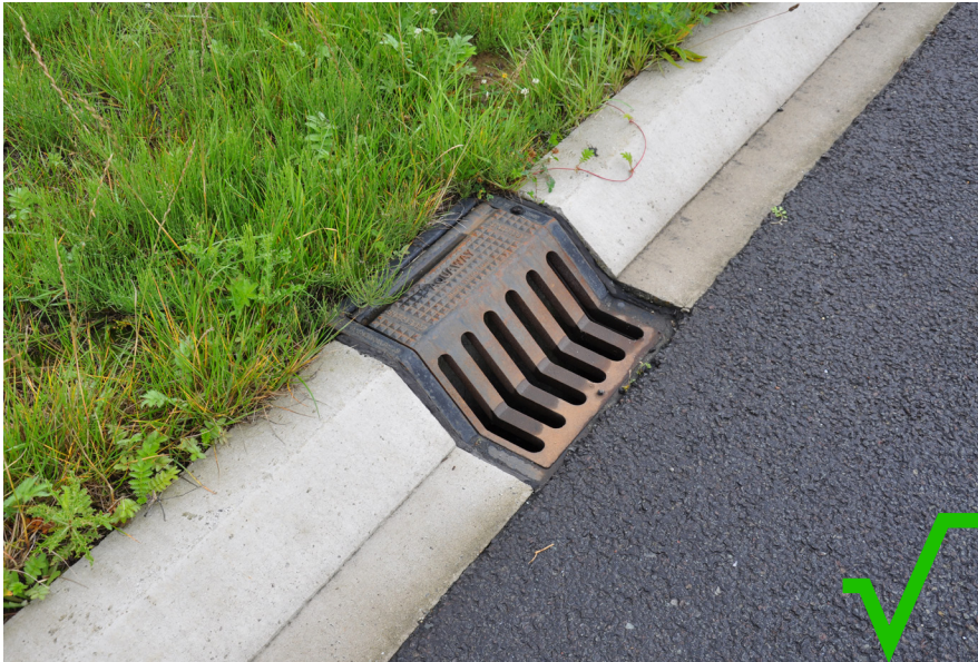
straatkolk volledig geïntegreerd in opsluitband
