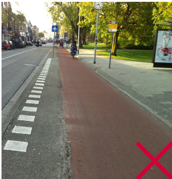
2 | standaard materiaal, onzorgvuldige aansluiting
