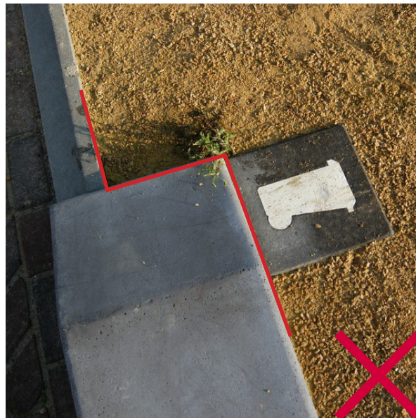
opsluitband sluit niet aan op halteband
