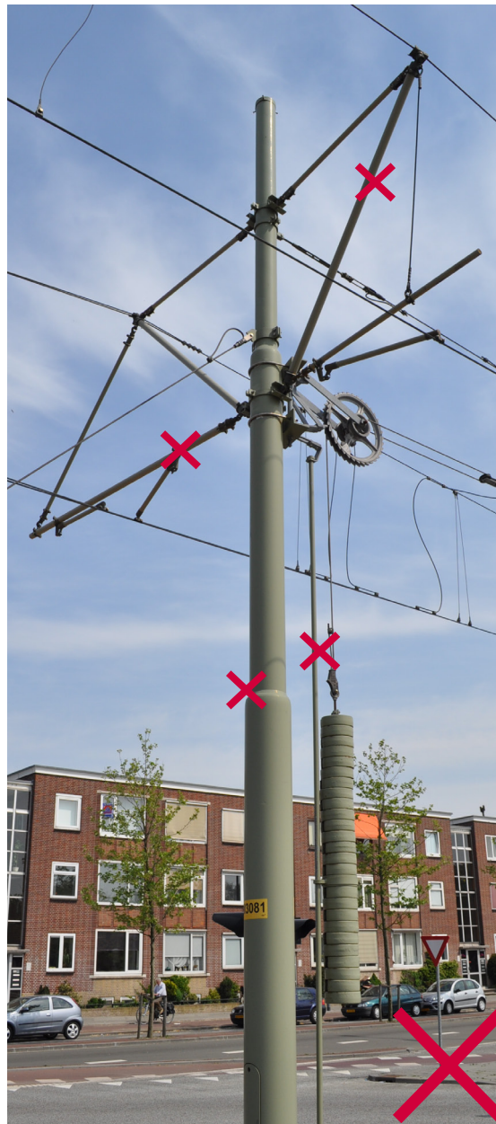
afspanningsconstructie extern, flessenhals, lomp
