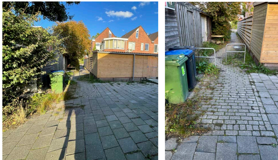
Doorgang belangrijke en intensief gebruikte voetgangersverbinding dient te worden verbeterd
