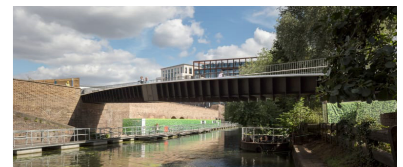
Foto van Somers stadsbrug, afkomstig van https://divisare.com/projects/366052-moxon-architects-arup-somers-town-bridge
