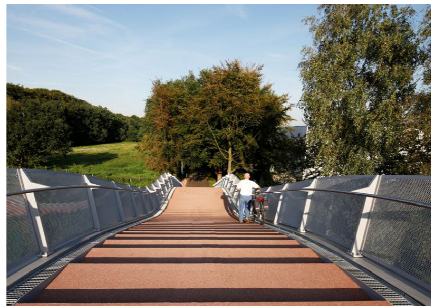
Referentie voor de fietstrap van de fietsloopbrug Voetgangers- en fietsersoversteek over de N31 in Brugge, België
