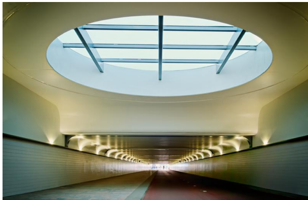
Afb: effect van daglichtvenster in Provenierstunnel Rotterdam. Kan ook open ingepast op perronniveau
