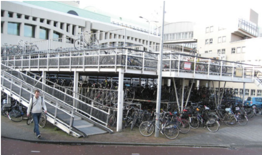
Afb: foto bestaande fietsflat, hier wordt nog een laag op gebouwd
