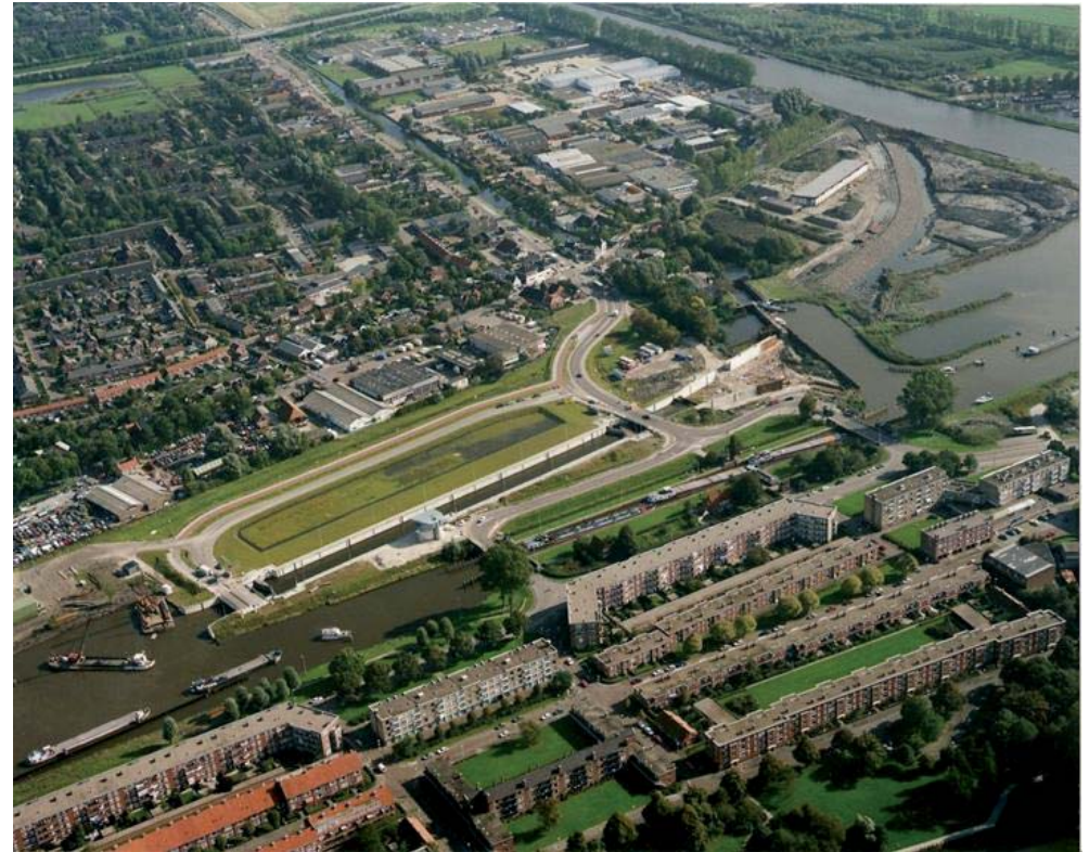
Het nieuwe sluisencomplex van de Oostersluis middenonder met het Eemskanaal rechtsboven, 1995. Tevens zijn zichtbaar de werkzaamheden ten behoeve van de bochtverruiming kruising Van Starckenborghkanaal met het Eemskanaal.
