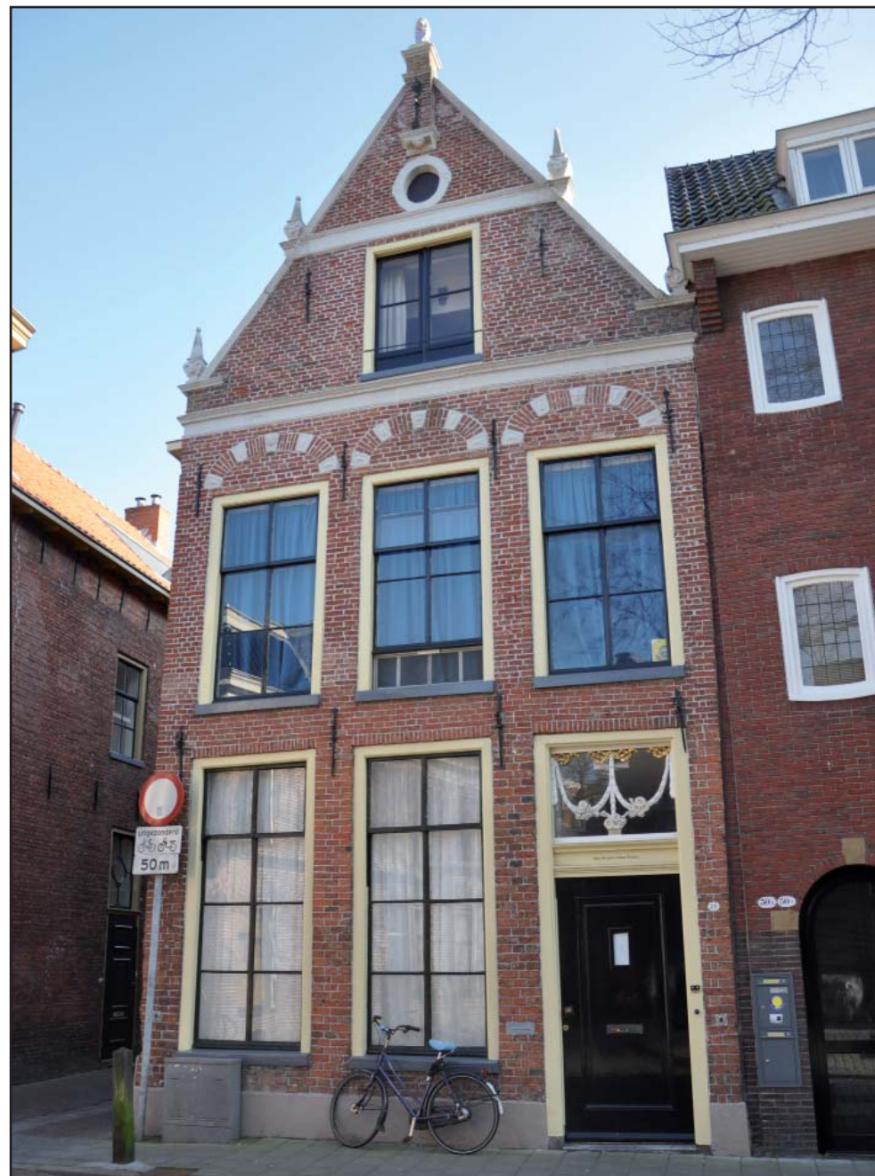
Turftorenstraat 28 met 17 e -eeuwse schoudergevel
