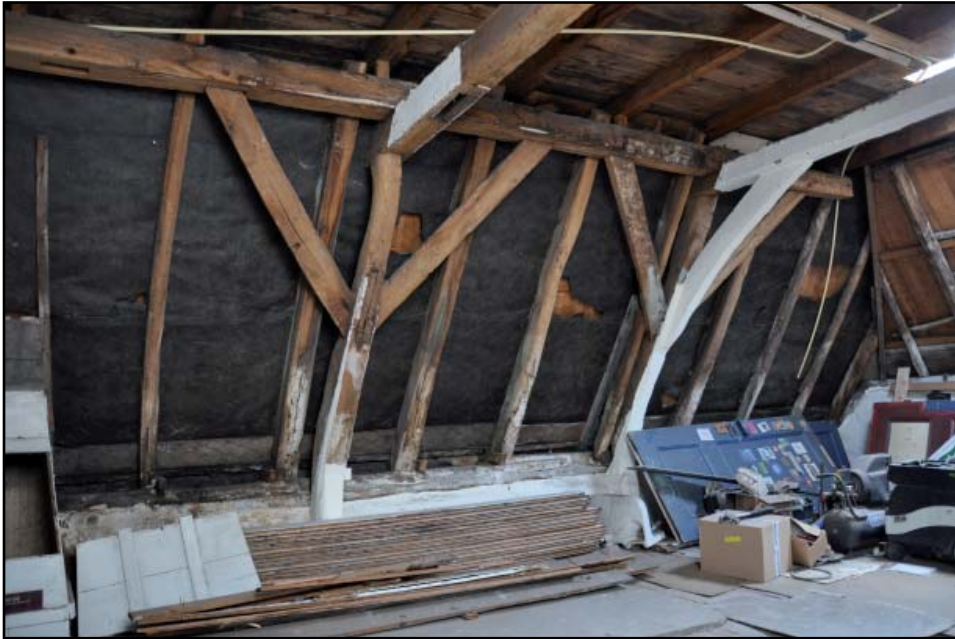
Oude Boteringestraat 51, eikenhouten kap met kromstijlgebinten uit 1444
