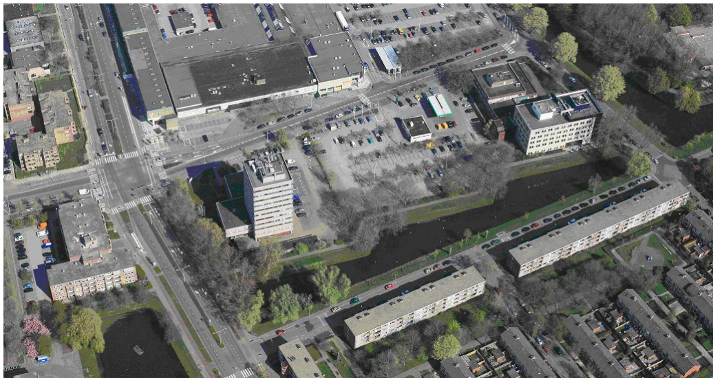
luchtfoto in zuid-noordrichting, met rechts het vml. UWV-GAKkantoor
