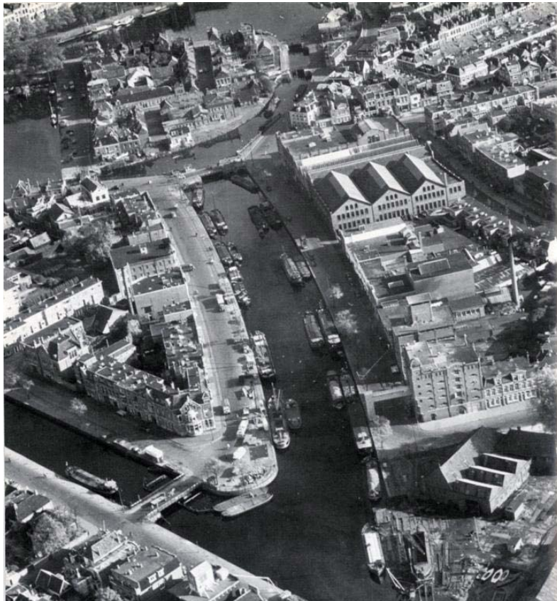
Luchtfoto. Hoendiep, Eendrachtskanaal gezien naar het oosten, circa 1950
