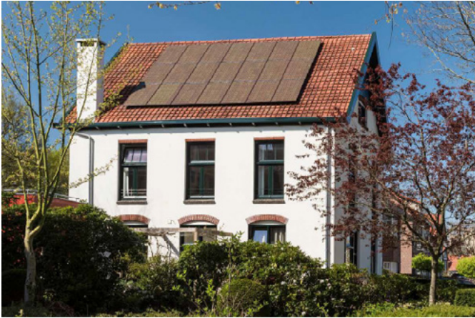
Figuur 9 Qua kleur bijpassende zonnepanelen. Bron: Groene gids; zonne-energie en uw monument.
