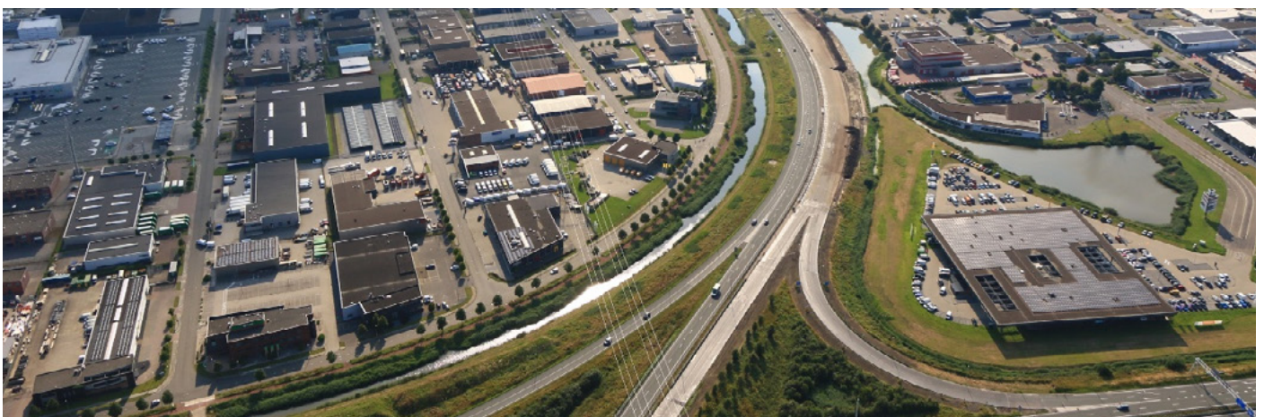
Figuur 7 Driebond en Eemspoort. Bron: Aanpak Ring Zuid/Rijkswaterstaat (aug 2021)
