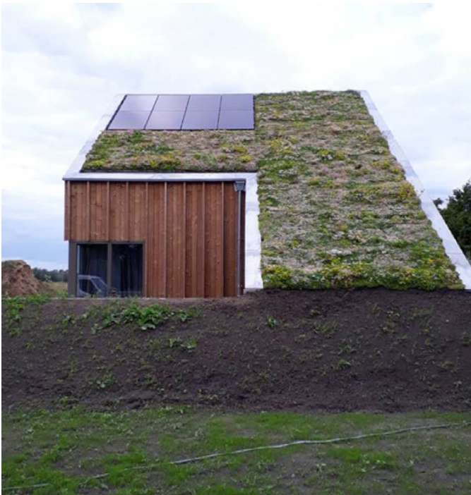
Figuur 2 Zonnepanelen en sedum dak op een schuin dak is ook mogelijk. Bron: Frisia Bergum
