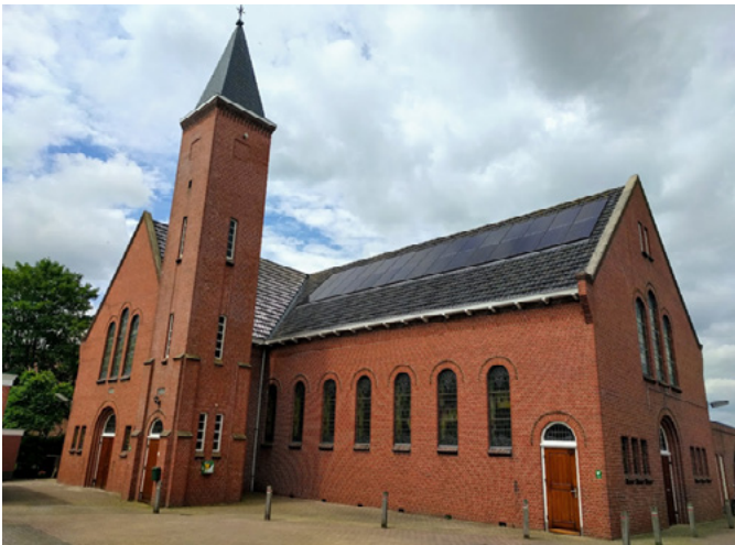
Figuur 8 Zonnepanelen geïntegreerd in dak Gereformeerde kerk Enumatil
