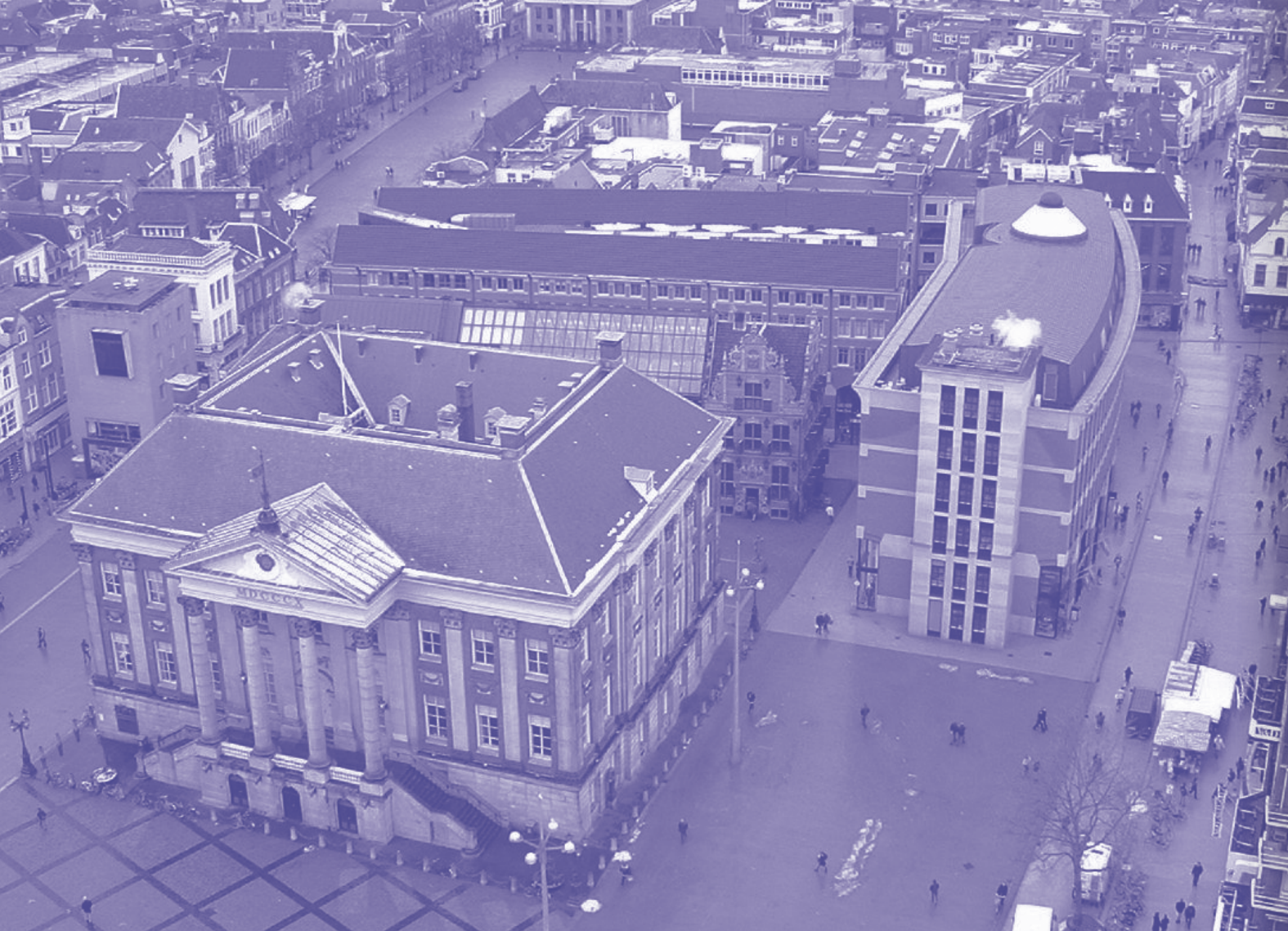
Sloop Nieuwe Stadhuis en prijsvraagontwerp Waagcomplex gerealiseerd.
