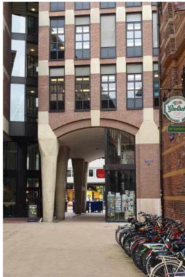
Onderdoorgang noordelijk deel Waagcomplex. De passage door het Waagstratcomplex is rommelig en onduidelijk. De Herestraat heeft hier een onbeduidend einde.
