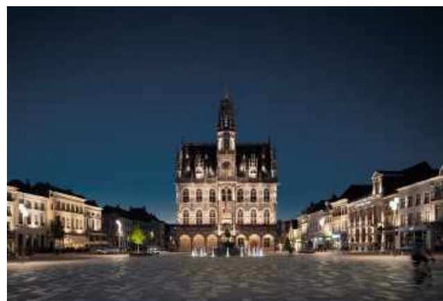
Verlichting met nadruk op de pleingevels en enkele bijzondere gebouwen. Markt, Oudenaarde (Abscis architecten en Atelier Roland Jéol)
