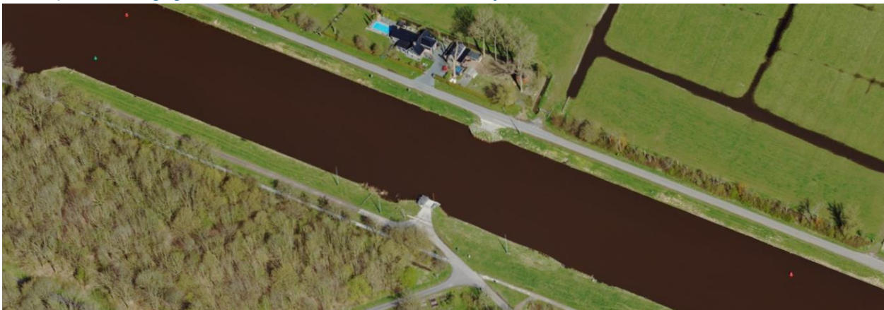
Figuur 1-1 Paddepoelsterbrug huidige situatie (bron: Streetsmart)
