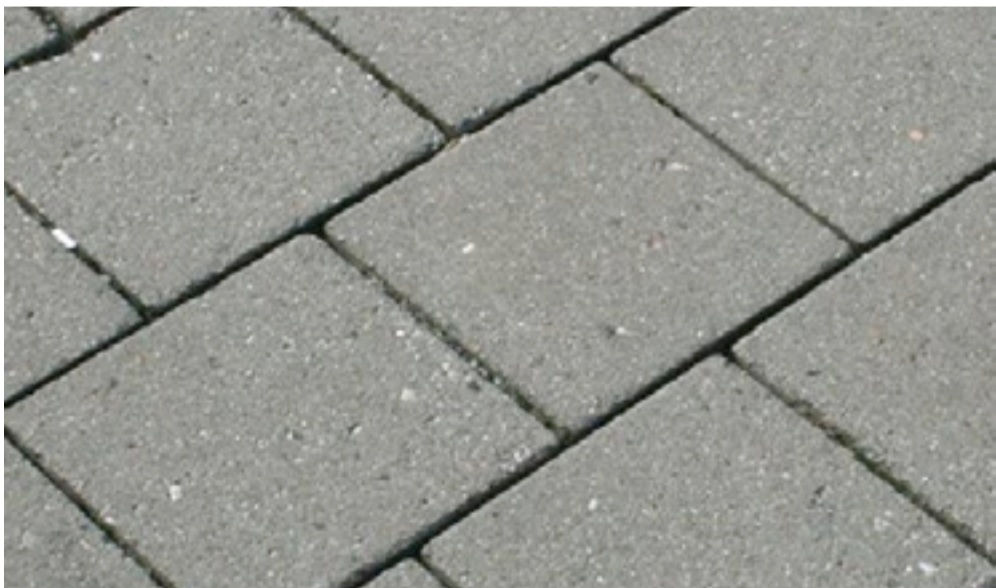
Verharding houdt langer warmte vast en zorgt ervoor dat er minder water kan infiltreren in de bodem.
