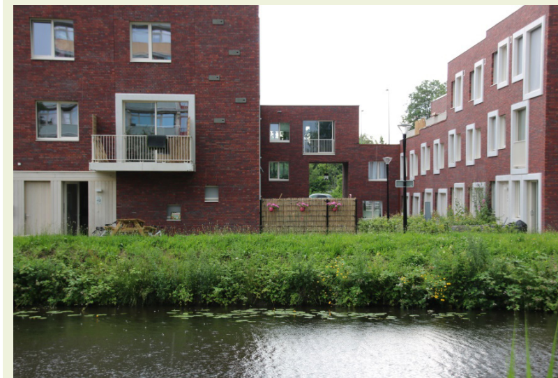
Figuur 8 Groene oever ter plaatse van Friesestraatweg 209 (bron: gemeente Groningen)
