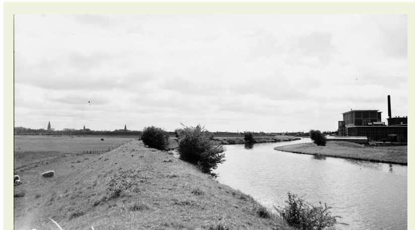
Figuur 4 Reitdiepdijk, zicht op binnenstad en melkfabriek de Ommelanden
