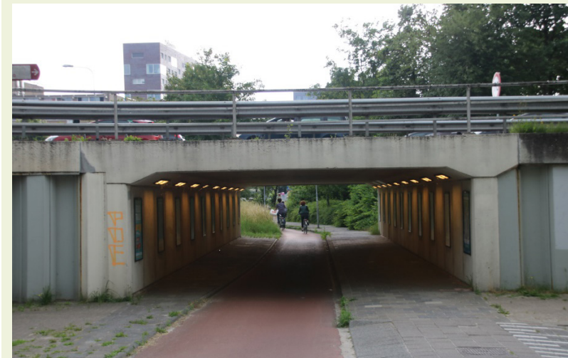
Figuur 9 Bestaande onderdoorgangen, boven: onderdoorgang Pleiadenlaan vanaf zuidkant, onder: onderdoorgang Ring West richting Vinkhuizen (bron: gemeente Groningen)
