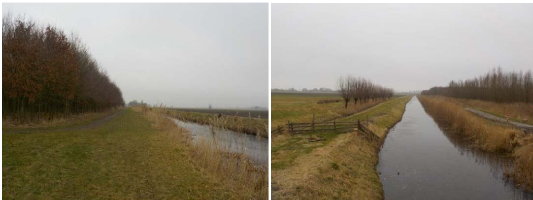
Foto 2 Het tracé vervolgt zijn weg over een brede watergang (de Zuidwending) waarna het over dijkje richting noorden loopt en aansluit op het huidige fietspad ter hoogte van Stadsweg 3.
