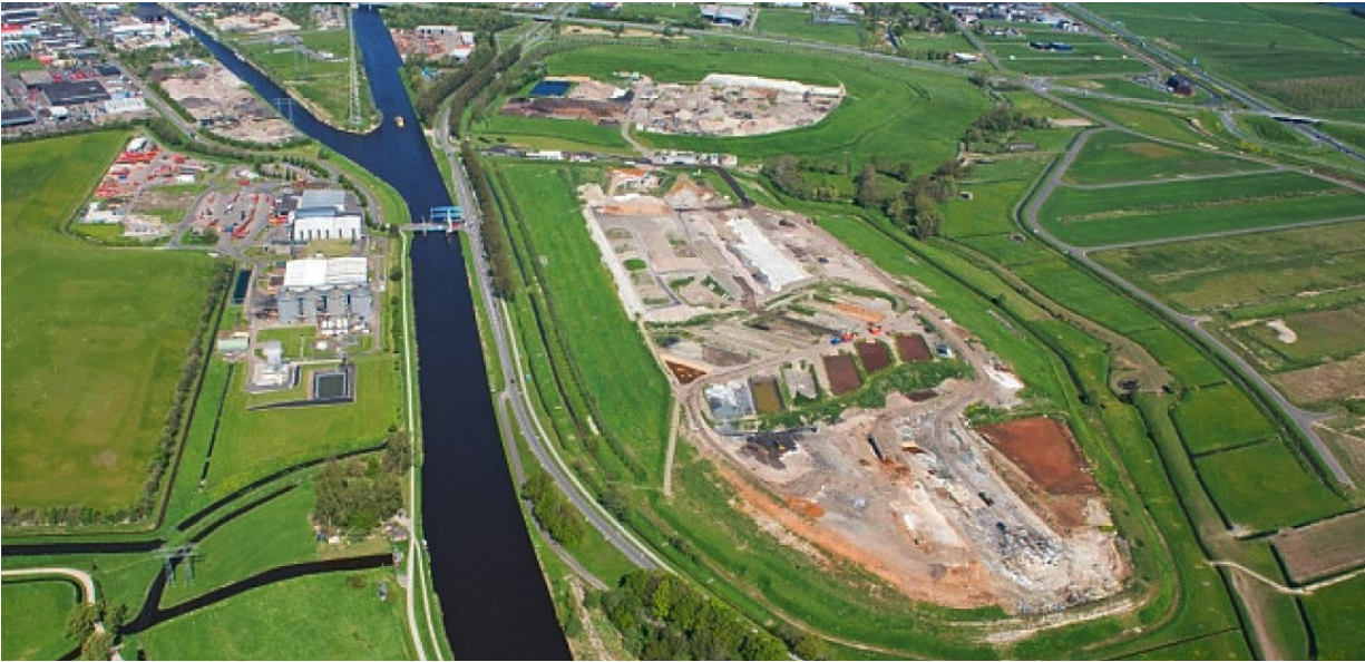
Stainkoeln-Roodehaan, beeld van het gevestigde recyclagebedrijf
