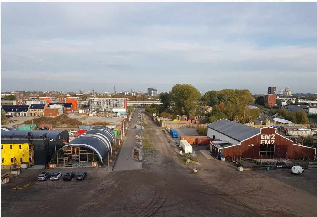
Zicht vanaf het Zeefgebouw richting binnenstad
