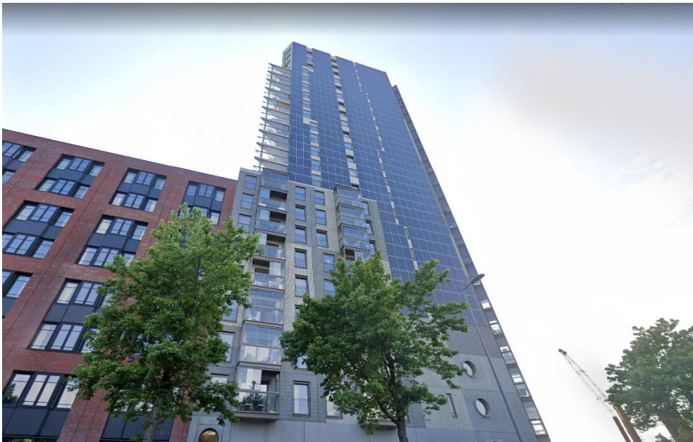
Figuur 7.1 Zonnepanelen op gevel in Amsterdam
