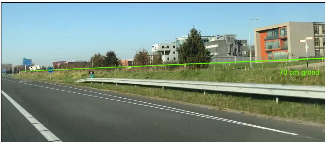
Figuur 8: Doortrekken grondwal
