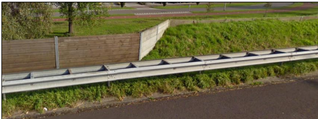
Figuur 5: De oude schermovergang (voor de busbaan)
