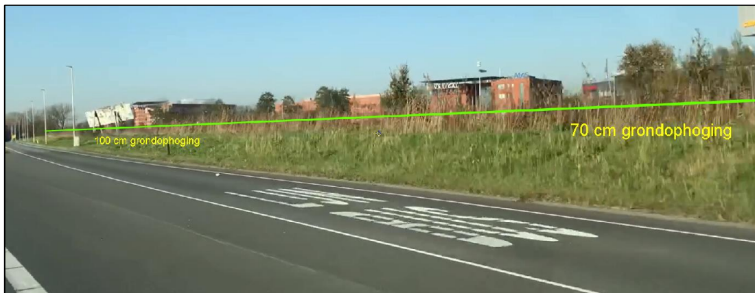
Figuur 9: Doortrekken grondwal naar het kunstwerk
