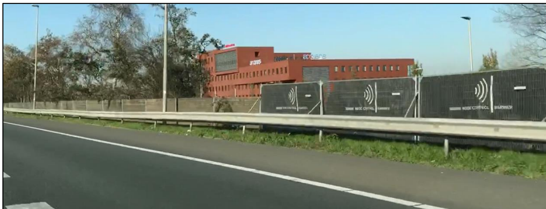
Figuur 3: Deel A sluit aan op het bestaande houten scherm en vervangt de Sound Shields
