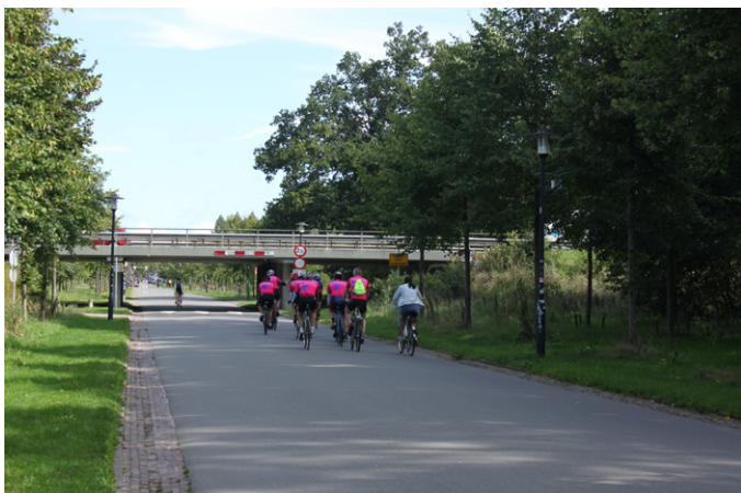
De Concourslaan in het Stadspark: nu de hoofdlaan dwars door het park die in directe verbinding staat met de toekomstige toegang van het hoofdstation
