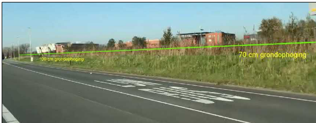
Figuur 9: Doortrekken grondwal naar het kunstwerk
