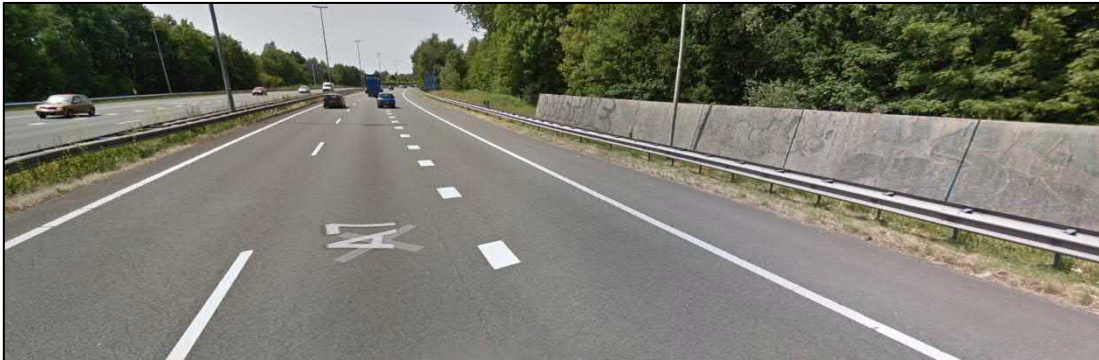
Figuur 28: Bestaande betonnen afscherming langs het sportpark
