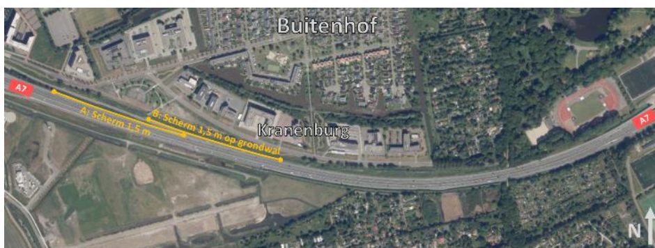
Figuur 2: Aanleg van geluidsschermen langs de noordzijde van de snelweg A7 voor het dichtmaken van het akoestisch gat in de wijk Buitenhof.
