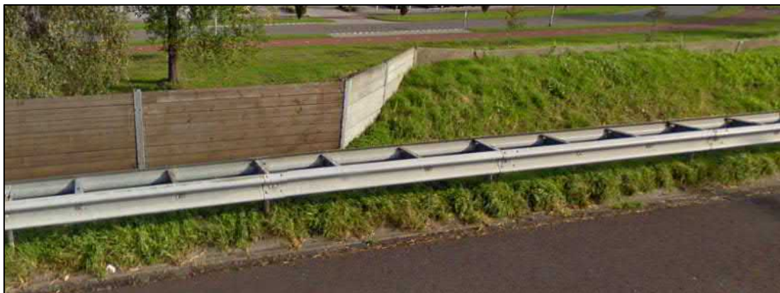
Figuur 5: De oude schermovergang (voor de busbaan)
