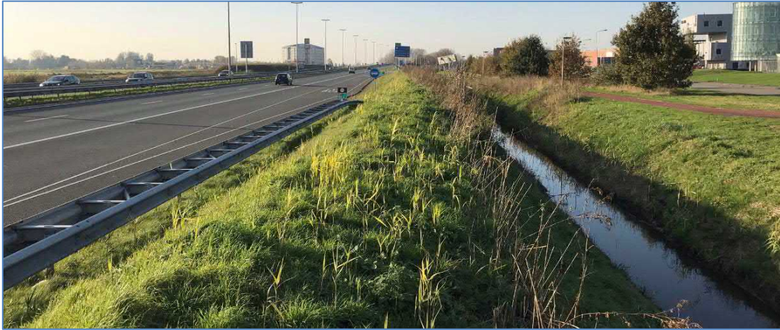
Figuur 24: Stuk waar de afslag voor de busbaan is aangelegd
