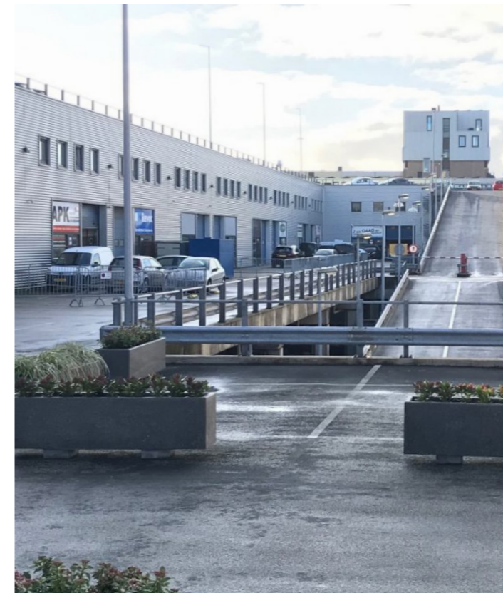
Binck twins, gestapeld bedrijfsgebouw, Den Haag
