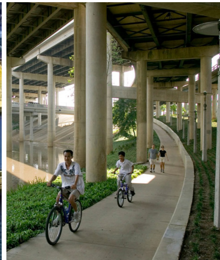
Onder de brug
