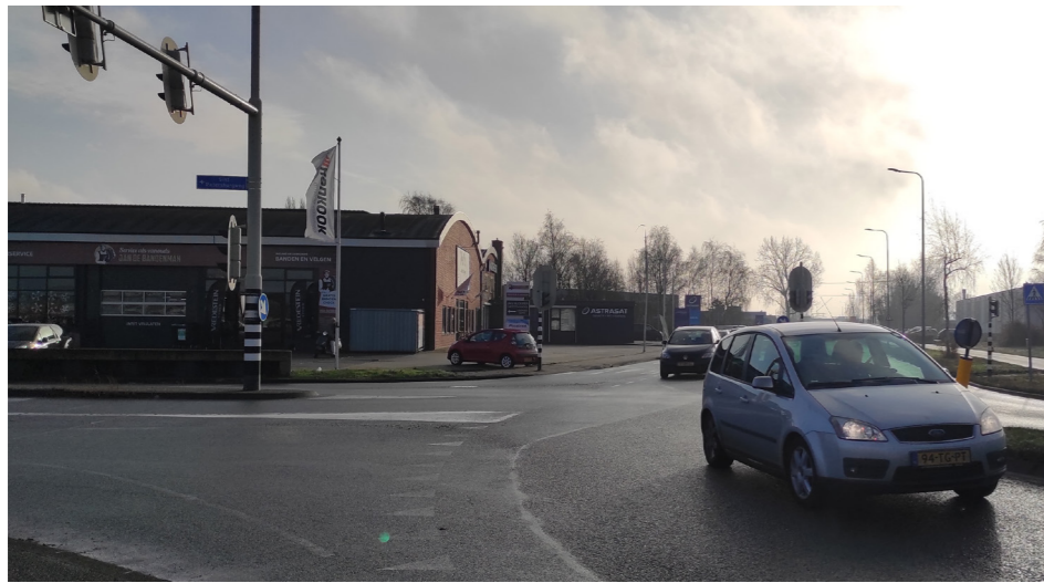
Bestaand bedrijfspand aan het kruispunt Sontbrug/Bornholmstraat
