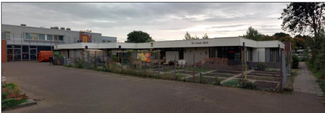
Figuur 1.3: De Oude Bieb, gezien vanaf de Kajuit (bron: Cyclomedia)
