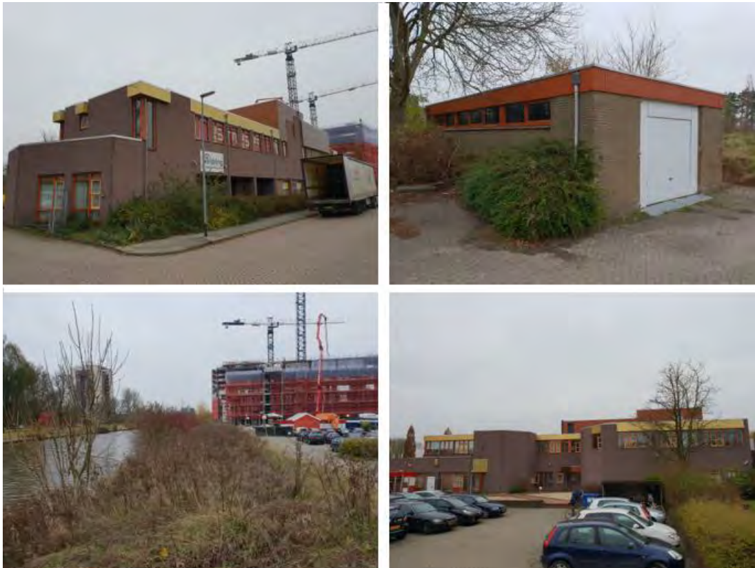
Figuur 3: Impressie van het plangebied met het kantoorpand voorzijde, aanwezige garage, watergang Reitdiep en de achterzijde van het kantoorpand. Foto's RHDHV 2018.
