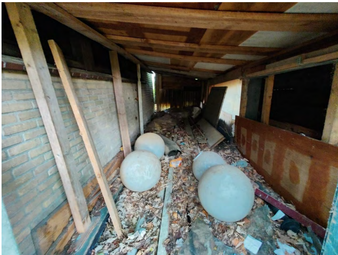
Figuur 3-1: Aanbouw bij de garage met rommel, die mogelijk kan dienen als verblijfplaats voor een steenmarter, bunzing en hermelijn. Foto RHDHV 2022.
