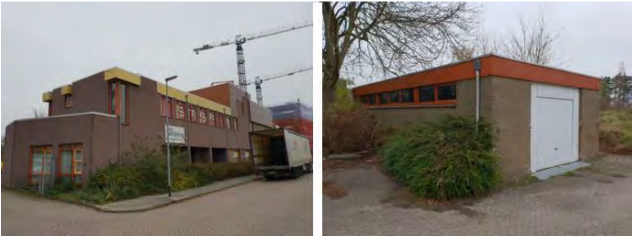
Figuur 2-3: Impressie van het plangebied met het kantoorpand voorzijde, aanwezige garage, watergang Reitdiep en de achterzijde van het kantoorpand. Deze situatie is onveranderd gebleven. Foto's RHDHV 2018.
