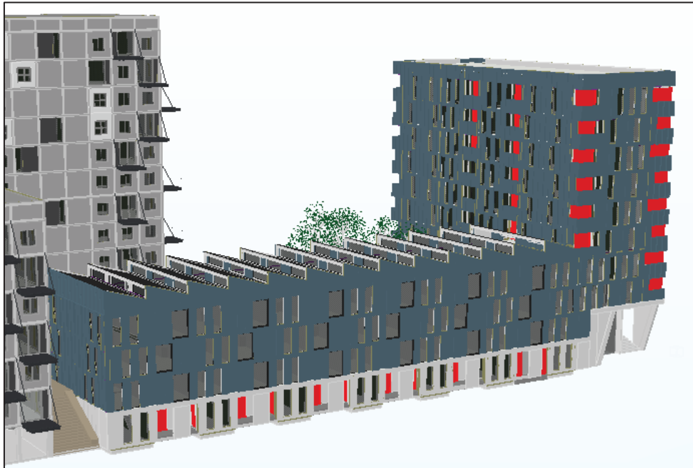
Figuur 6: Loggia's met maatregelen
