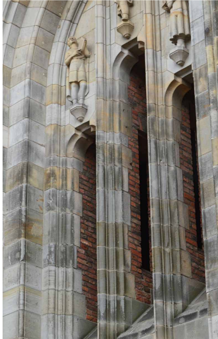
Martinitoren westzijde: Baksteen met verkleiding Natuursteen
