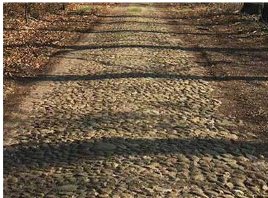
Flinten (Drentse kleine kasseien, die over de hele Hondsrug te vinden zijn), Bron: https://indekopgroep.nl/dokkeren-over-de-langste-kasseienstrook-van-nederland/
