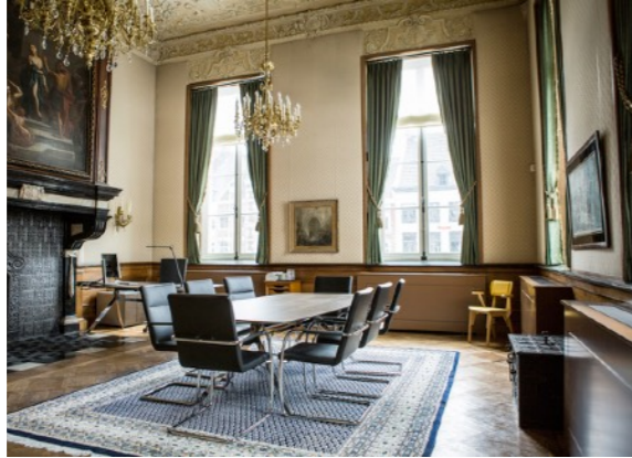
Fancoilunits en nieuwe lambrisering voor leidingverloop
