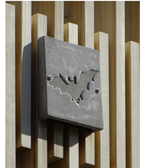
Inbouwsteen voor vleermuizen.
