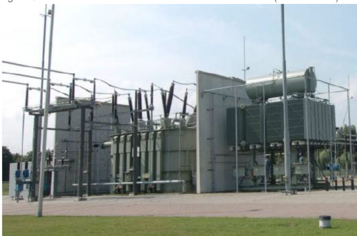
Figuur 5.2 Voorbeeld transformator in een transformatorcel (scherfmuren)
