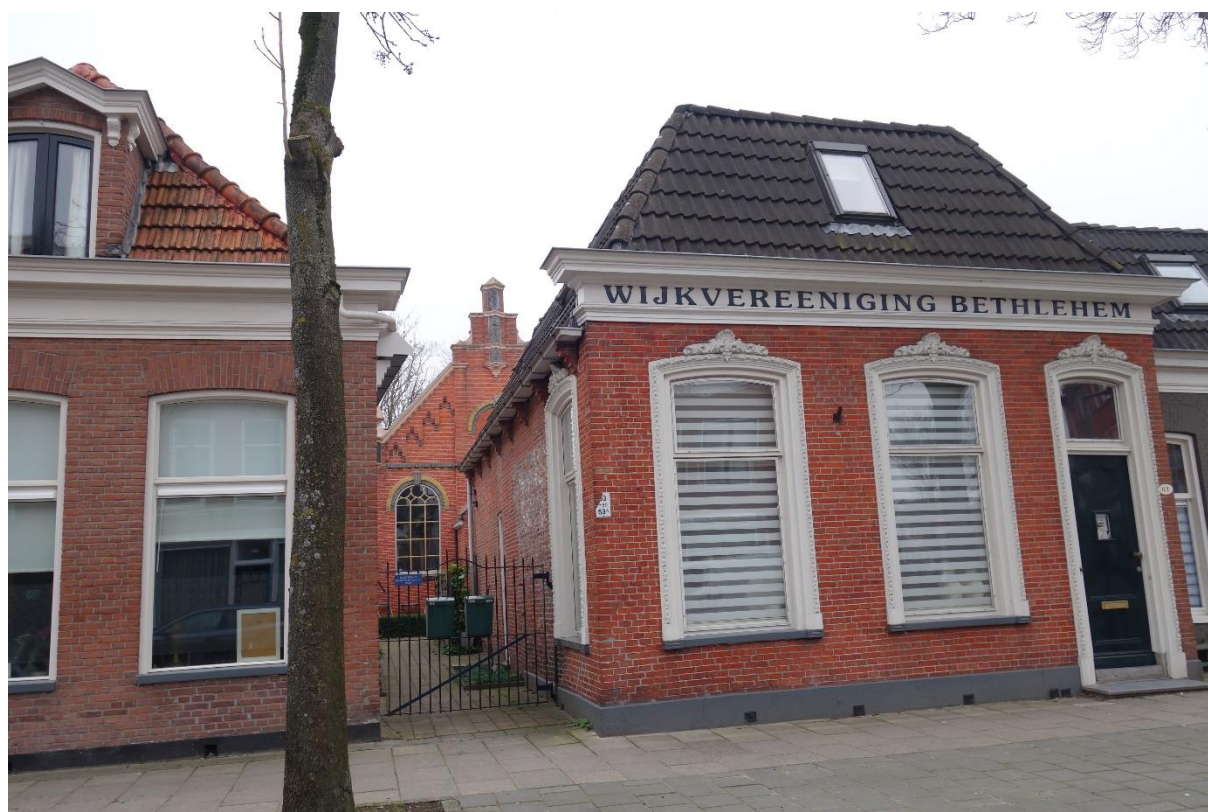
Figuur 45. Het voormalig wijkgebouw Bethlehem aan de Meeuwerderweg 63-63a ligt binnen het stedenbouwkundig ensemble van de Oosterpoortbuurt.
